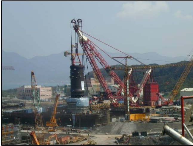
Lungmen ABWR Construction
