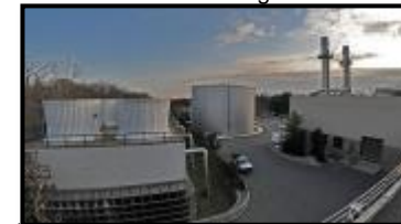
(Princeton U. cogen plant)
